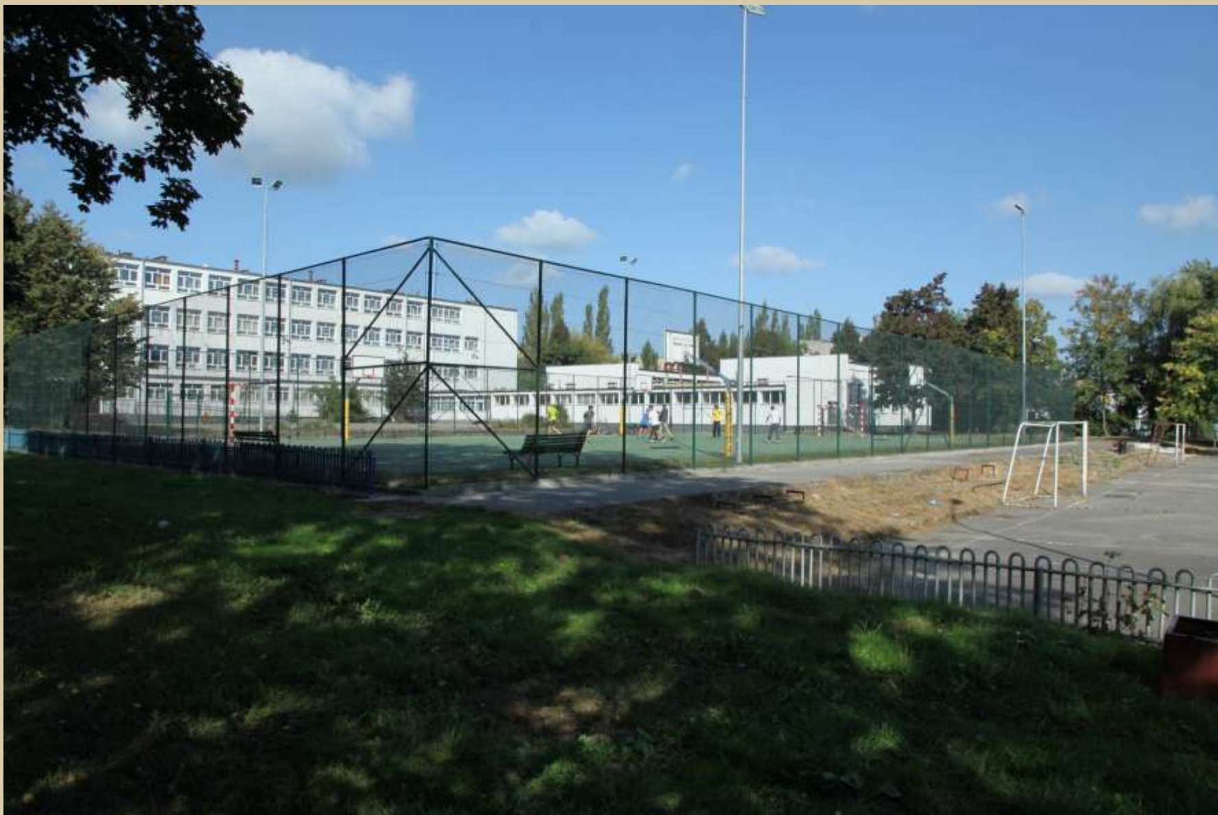
Boisko wielofunkcyjne przy Zespole Szkół im. Ks. S. Staszica, ul. Kopernika 1
