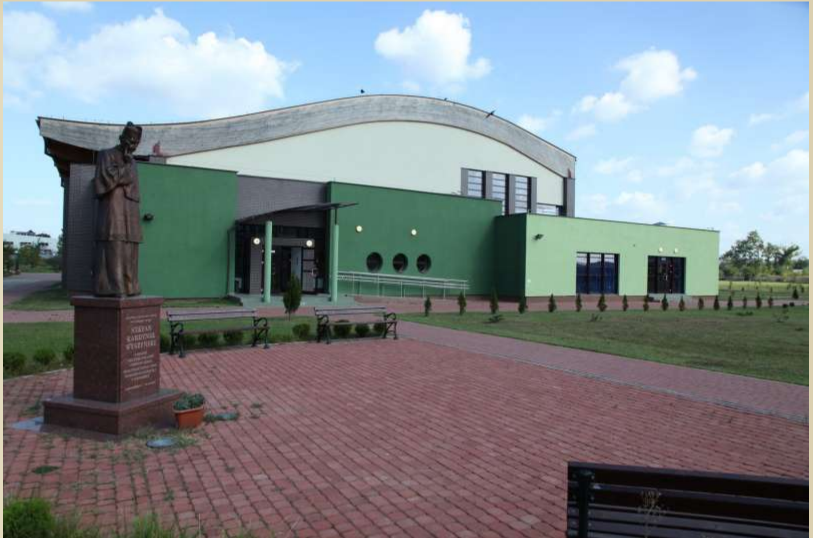
Hala Sportowa przy ZSP Nr 1 w Tarnobrzegu, ul. Kopernika 49
